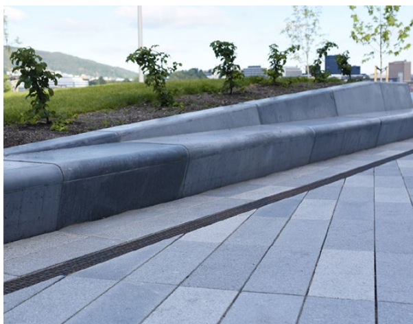
NOBI har levert betongelementene til prosjektet. FOTO: Svein Boasson AS.
