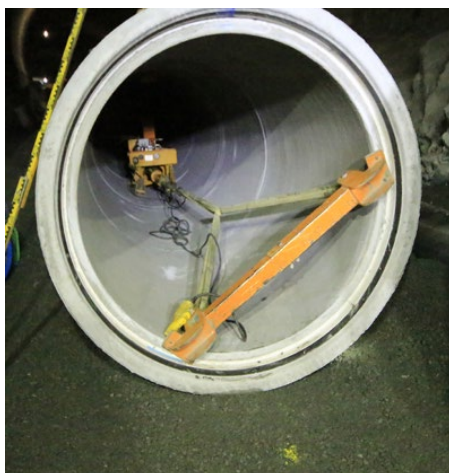
Spesialverktøy brukes for å trekke rørene sammen.
