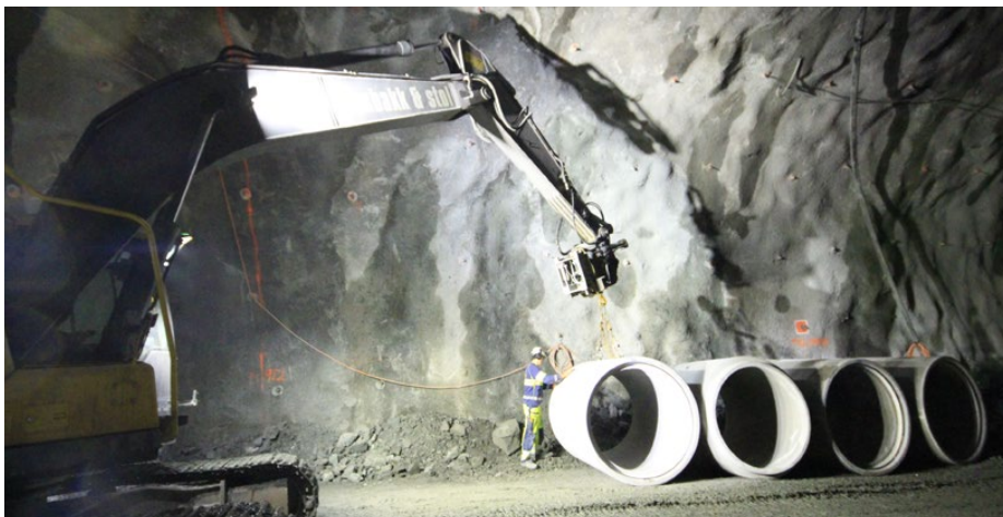
De tunge betongrørene krever samarbeid mellom NOBI-transport og Vassbakk & Stol.
