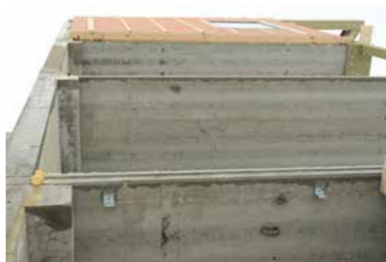
Gjeraldstveit Mekaniske AS monterte både hulldekkene og stålet. Selve monteringen gikk på 2,5 uker.
