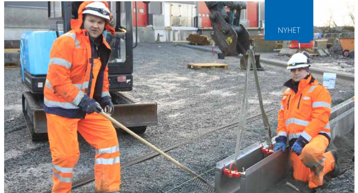
Bergen Rørteknikk AS monterer drensrennene på nye Tine Meierier på Espehaugen. Totalt leveres 285 meter med drensrenner.
