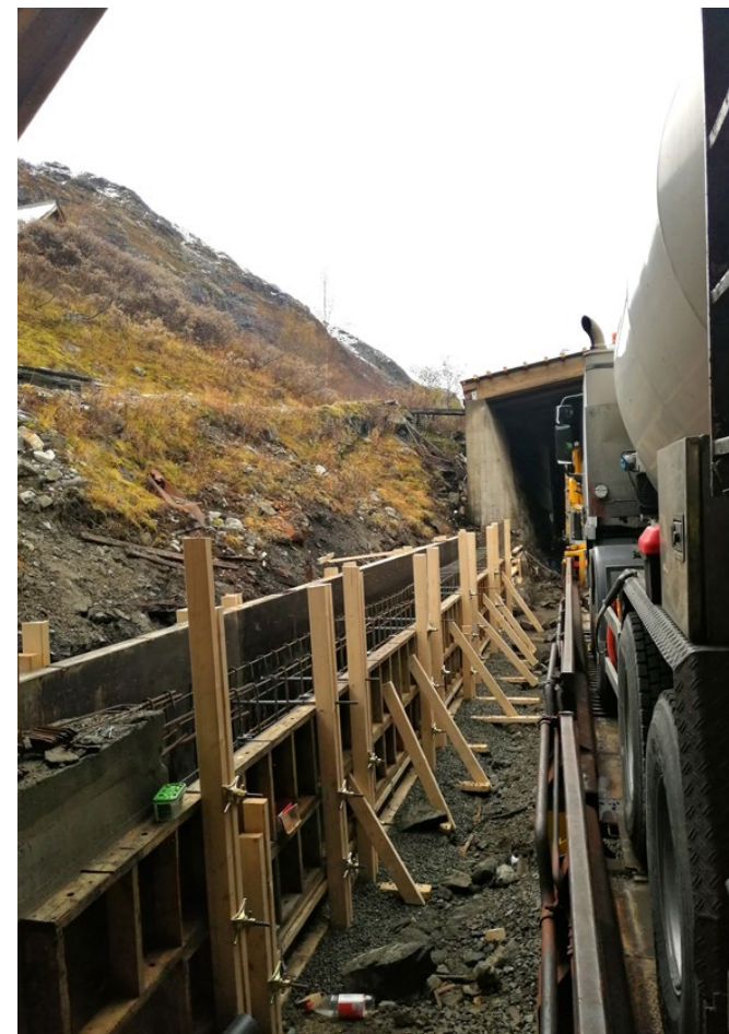
Leveranse av 1 lass betong til støpping av mur på Myrdal stasjon 15.10 for Atec Voss AS.
