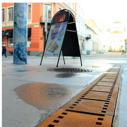
BERGEN KINO: Forhåndsrustet cortenstål, spesialutforming.
