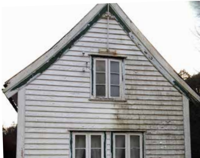
DeSalin AM påført med lavtrykksprøyte, tynnet ut 1:5 med vann, på malt overflate i -7 grader.
